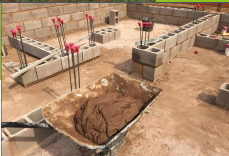
Blocos de concreto produzidos a partir de rejeito de minério
