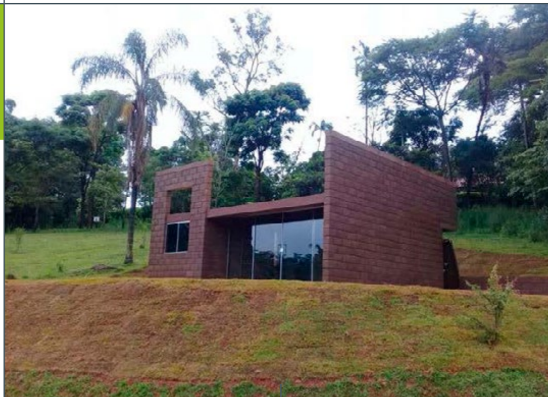
Blocos de concreto produzidos a partir de rejeito de minério
